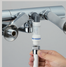
ウルトラファインバブル発生装置の取り付け箇所
